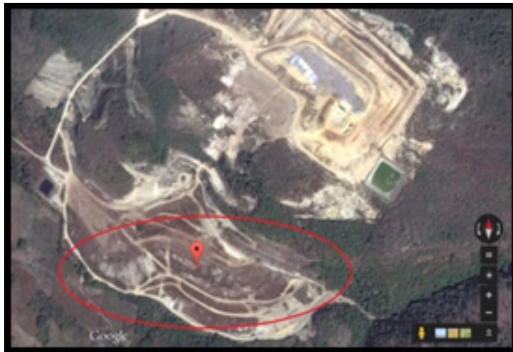
Figura 1. Zona clausurada del relleno sanitario.
