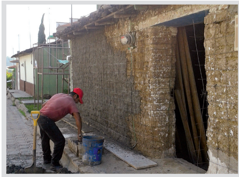
Figura 12. Aplicación del mortero cemento-arena
