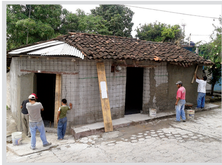
Figura 6. Aplicación de la segunda capa de mortero cemento-arena
