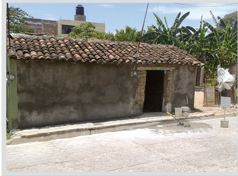
Figura 13. Aplicación del mortero cemento-arena
