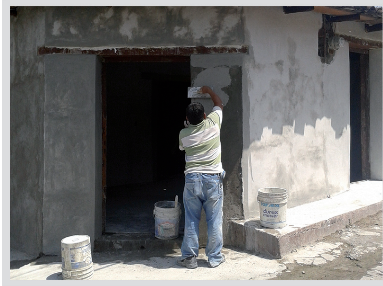
Figura 7. Enmasillado con cemento-calhidratada
