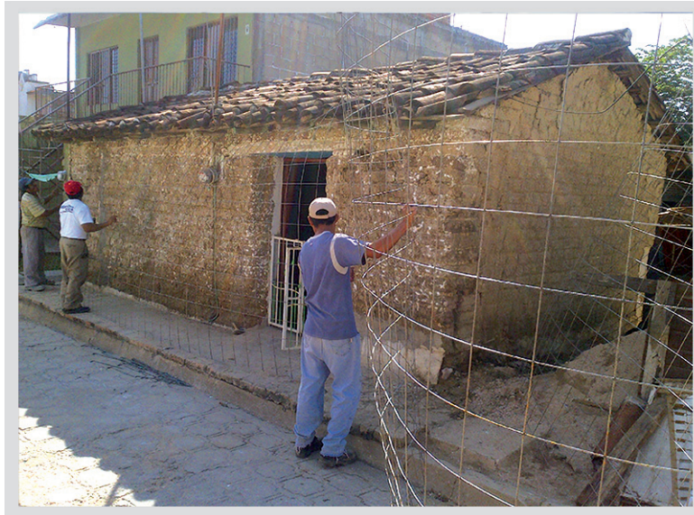
Figura 10. Colocación de la malla electrosoldada
