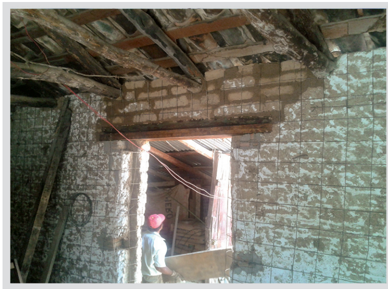
Figura 9. Reforzamiento del dintel existente con tablón de madera de pino.
