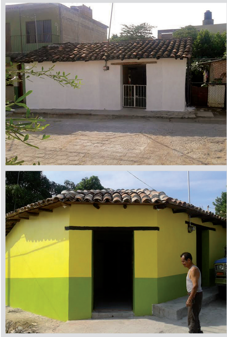
Figura 14. Resultado del reforzamiento estructural en las viviendas.
