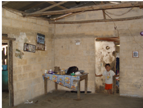
Figura 3. Vivienda típica con muros de bloques huecos
