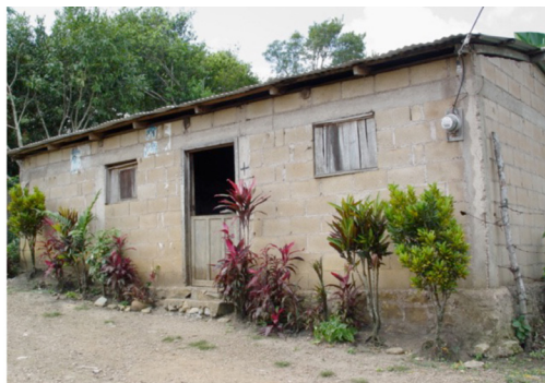
Figura 3. Vivienda típica con muros de bloques huecos
