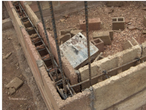
Figura 9. Refuerzo horizontal intermedio
