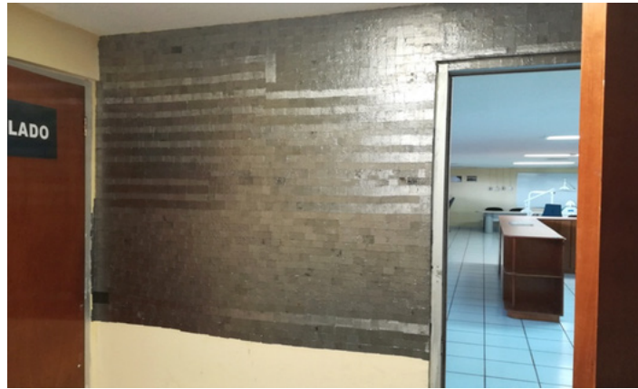
Imagen 3. Pared en proceso de forrado con laminillas de plomo, material contaminante de desecho radiográfico
