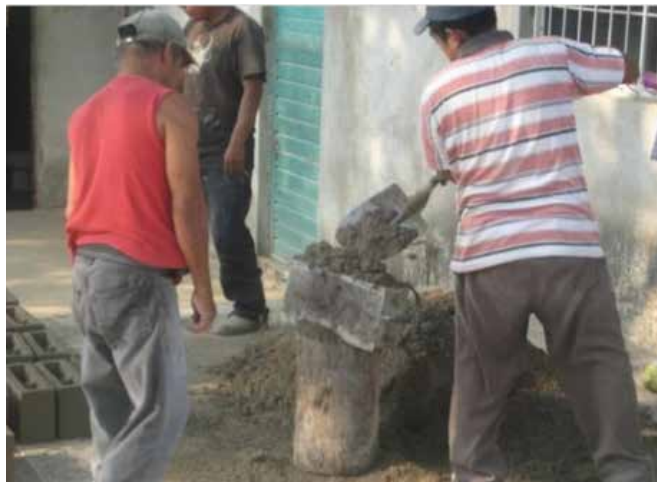
Imagen 11. Proceso de elaboración de bloques. Fuente: Elaboración propia
