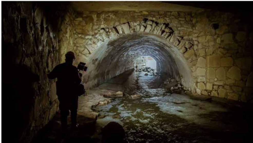
Figura 9. Vista general de un tramo del embovedado de piedra (Tavera, 2018)
