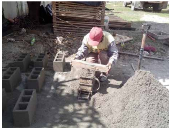
Imagen 16. Proceso de fabricación del bloque. Fuente: Elaboración propia
