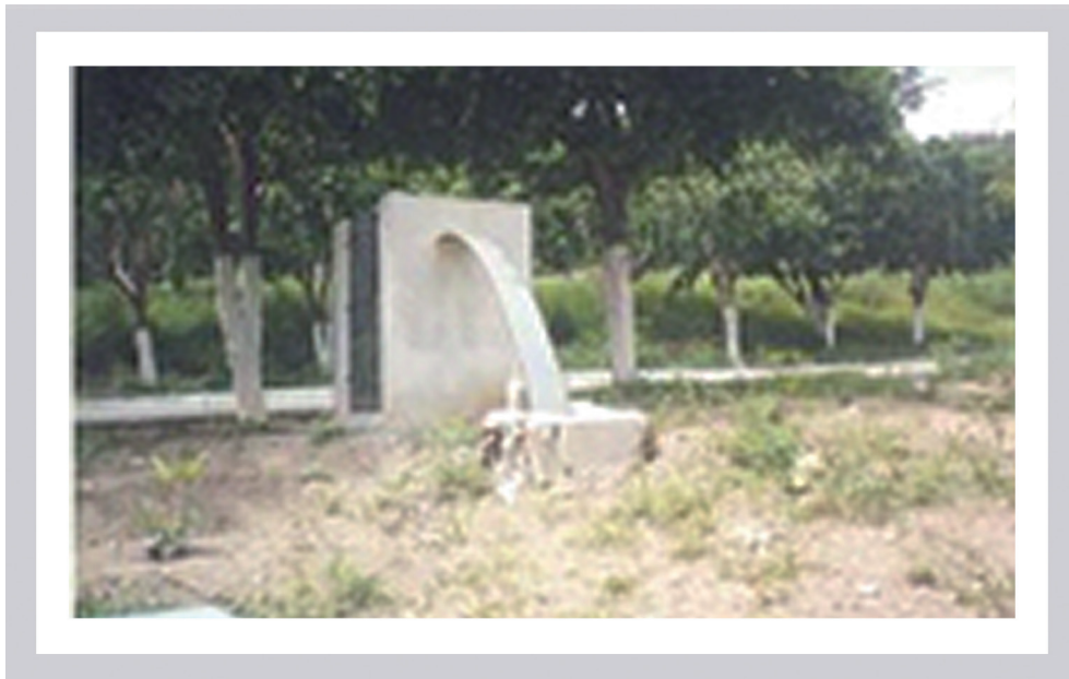
Foto 10. Tanque con sifón laminado
