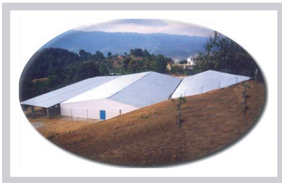
Foto 1. Colector de agua de lluvia, Yalentay, Zinacantán, Chiapas.
