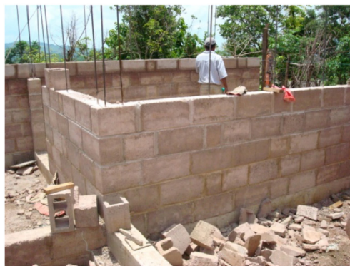
Figura 8. Construcción de los muros reforzados
