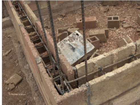
Figura 9. Refuerzo horizontal intermedio
