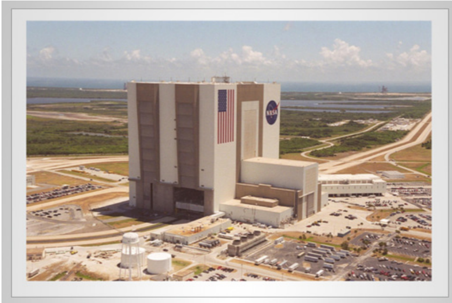
Figura 4. El Edificio de Ensamblaje de Vehículos (VAB) fue construido para el programa Apolo (1964). El VAB fue diseñado para albergar y ensamblar el Cohete Saturno V de 110 metros de altura. Una de las características más notables del VAB son sus puertas de 139 metros de altura (que son las puertas más altas del mundo). El VAB también se utilizó para el montaje del Transbordador Espacial de la NASA. El VAB se utilizará para el montaje/ensamblaje del SLS y el MPCV. Foto cortesía de la NASA.
