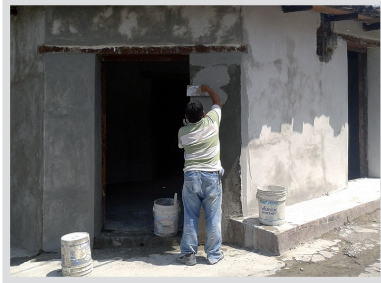
Figura 7. Enmasillado con cemento-calhidratada
