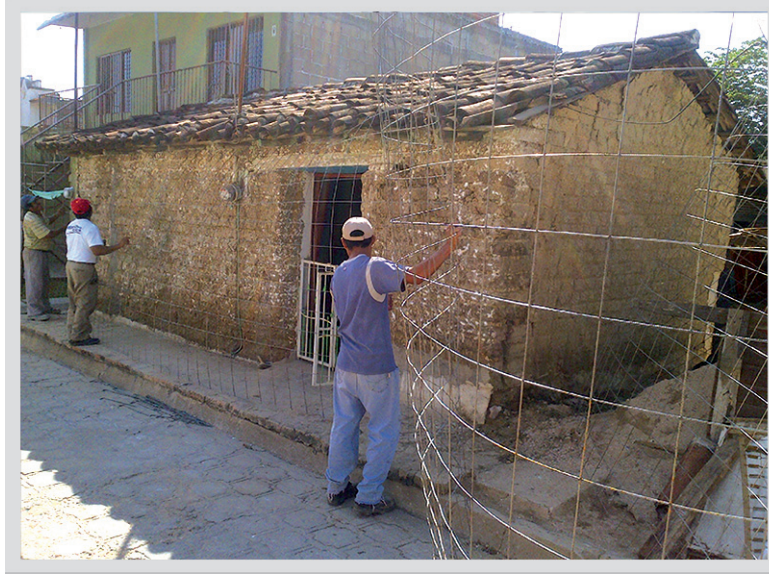
Figura 10. Colocación de la malla electrosoldada
