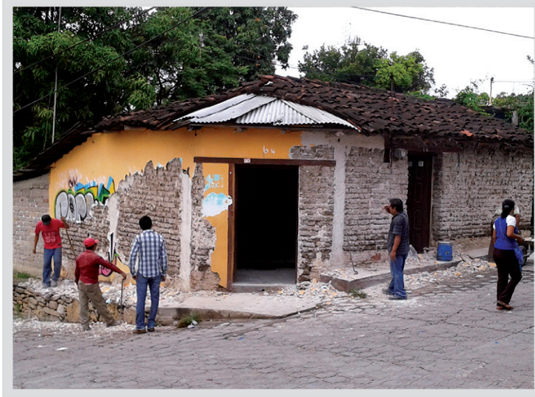
Figura 4. Eliminación del mortero existente en la vivienda
