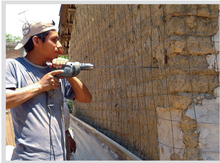
Figura 11. Barrenado del adobe para fijar la malla de acero
