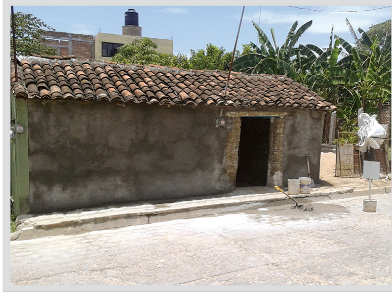
Figura 13. Aplicación del mortero cemento-arena
