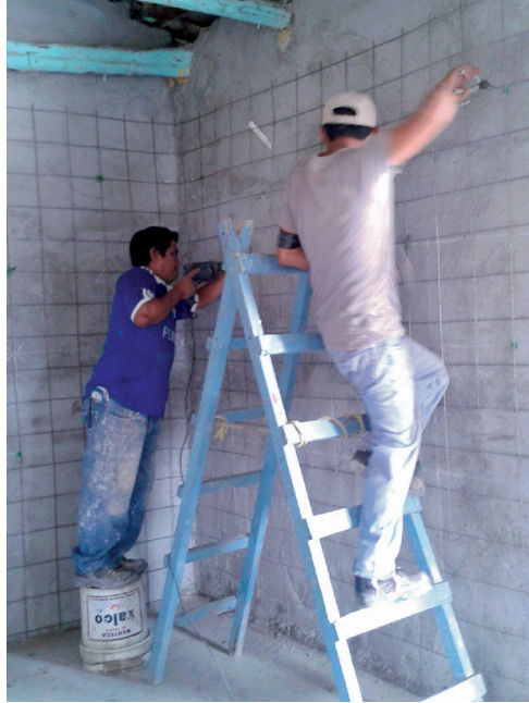
Figura 5. Colocación de la malla electrosoldada 6x6/10x10 al interior de la vivienda
